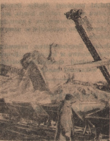
Przy pracach nad odgruzowaniem Warszawy czynne są również buldożery. Potężne szczęki tych maszyn za jednym zamachem wypełniają gruzem cały wagonik kolejki. (Foto — IKP)
