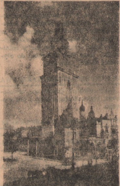
Wieża ratuszowa w Krakowie z odwachem austriackim, który zburzono jako pozostałość z czasów niewoli.
