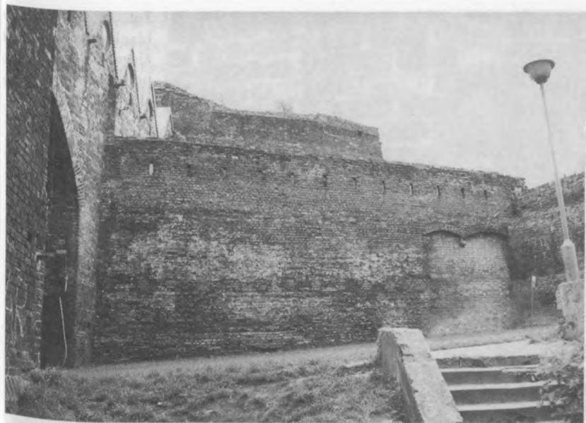
Fot. 8. Bastion z pocz. XVII w. wzniesiony w miejscu międzymurza zamku głównego. Odcinek po stronie północnej od Gdaniska, zwieńczony murem ze strzelnicami do broni ręcznej. Fot. M. Furmaniuk
