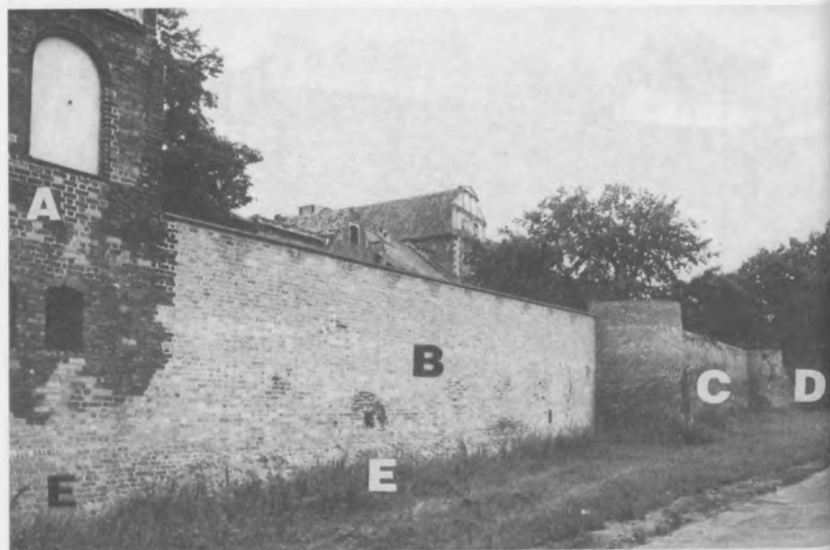
Fot. 3. Mur zachodni fosy zamkowej, odcinek południowy i środkowy. A – Dwór Mieszczański, B – przebudowany mur budynku z piecem, C – przebudowany mur budynku z trzema piwnicami, D – mur wzniesiony w 2. poł. XV w., E – podbudowania skośna przypora. Fot. B. Horbaczewski 1988
