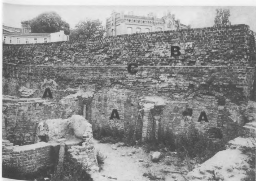
Fot. 2. Mur między fosą zamkową i międzymurzem. Fragment po budynku z trzema piwnicami. A – otwory drzwiowe zamurwane w 2. poł. XV w., B – mur z 2. poł. XV w., C – uskok wyznacza poziom nasypu. Fot. B. Horbaczewski 1988
