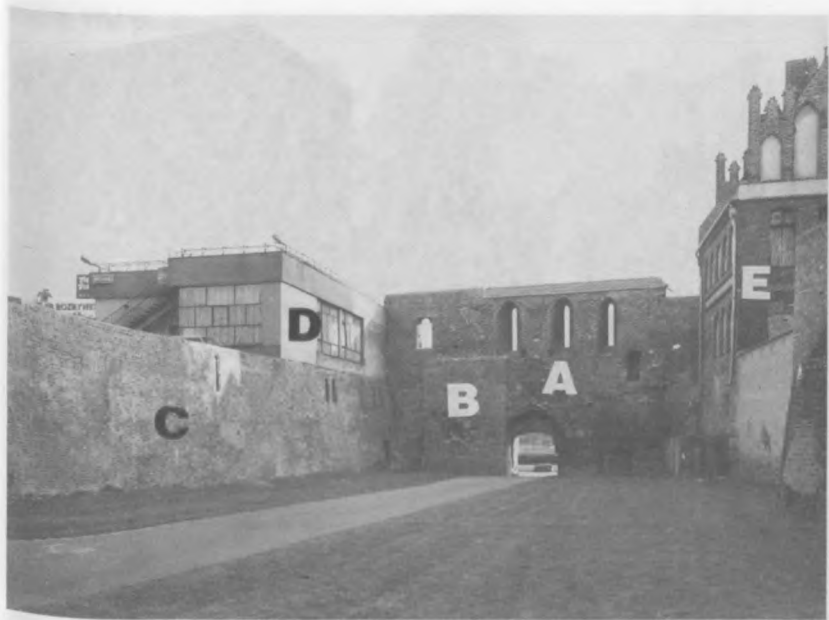
Fot. 4. Część południowa fosy zamkowej. A – mur z trzema oknami zamykający fosę od strony południowej, B – przemurowanie nowożytne, C – mur wschodni fosy zbudowany w pocz. XVII w., D – Klub Rozrywki „Zamek”. Fot. M. Furmaniuk
