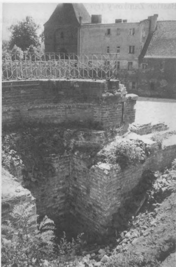
Fot. 6. Wał po stronie północnej Stawu Komtura. Prostopadła, wcześniejsza część baszty półcylindrycznej w murze oporowym wału. Fot. B. Horbaczewski 1988
