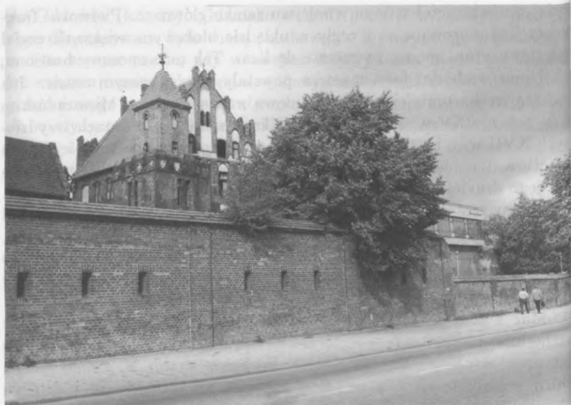
Fot. 12. Mur przy zamku wzdłuż Wisły, zbudowany w r. 1613, przebudowany w 2. ćw. XIX w., częściowo wyburzony przed r. 1966. Fot. M. Furmaniuk
