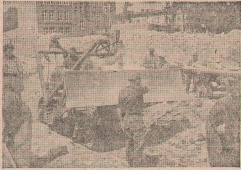
Maszyny do usuwania gruzów przy budowie autostrady Gdańsk — Gdynia.
