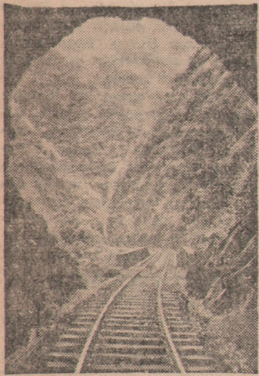
Ślimaczym torem z tunelu na most i w głęboki wąwóz.
