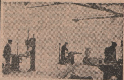
Hala obrabiarek po odbudowie.
