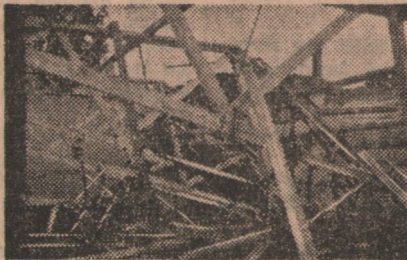
Hala traków przed odbudową.
