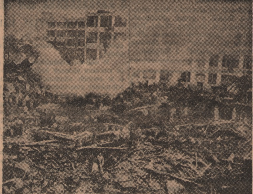
Los Angeles stało się terenem strasznego w swych skutkach wybuchu zbiornika zawierającego niebezpieczny kwas. W wyniku wybuchu rozbita została na atomowe niemal cząstki 2-piętrowy gmach fabryczny, a uszkodzonych zostało około 300 budynków na przestrzeni 1 mili kwadratowej. Spod gruzów rozsypanego w proch budynku fabrycznego wydobyto 42 zabitych i 100 ciężko rannych. Przepuszczalnie jednak liczba śmiertelnych ofiar wynosi około 75 osób, zaś liczba rannych — 300.
