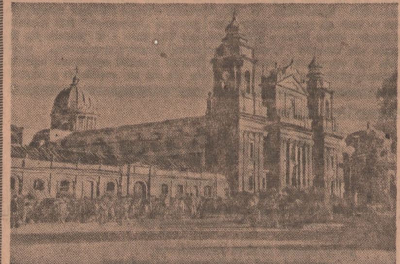
Kościół katedralny w Guatemali odbudowany po zniszczeniach, jałkich doznał w czasie trzęsienia ziemi w 1917-18 r.
