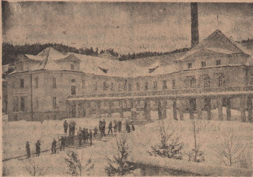
Nowe lazienki mineralne w Krynicy, w których przewidziano 235 wanien dla kąpiei mineralnych
