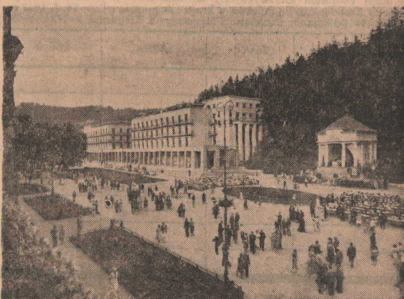
Nowy komfortowy hotel zdrojowy w Krynicy, mogący pomieścić 200 osób, który wojsko ma oddać zakładowi do użytku publicznego jeszcze w tym roku
