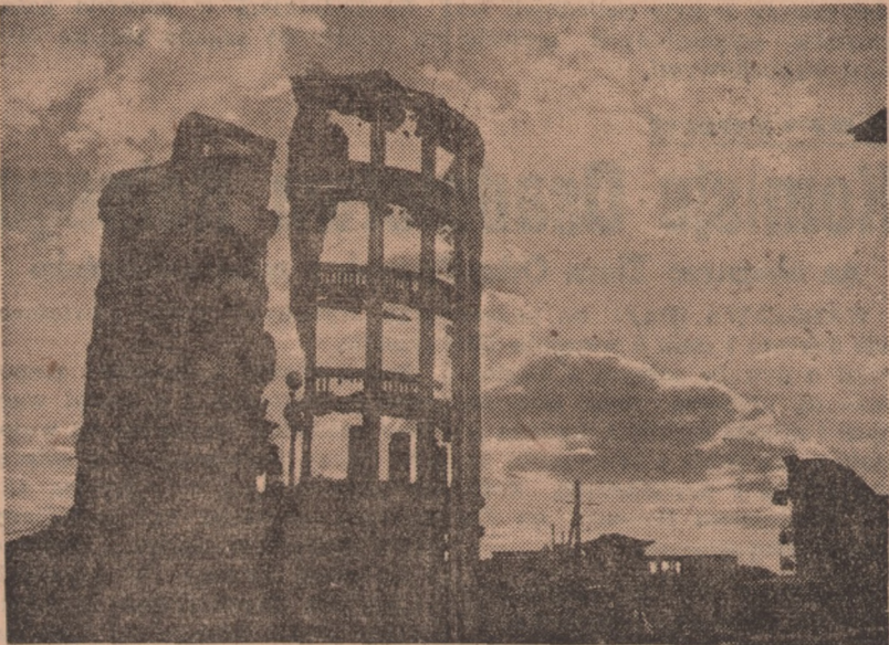
Podobnych widoków w Stalingradzie jest jeszcze b. dużo, szczególnie w centrum miasta. Skielety spalonych, względnie zburzonych domów najwymowniej świadczą o olbrzymim nasileniu walk toczonych tu przed czterema laty. Mimo wielkich wysiłków rządu i robotników ZSRR, potrzeba będzie jeszcze długich lat zanim zetrą się całkowicie ślady ran zadanych Rosji przez hitlerowskie hordy.
