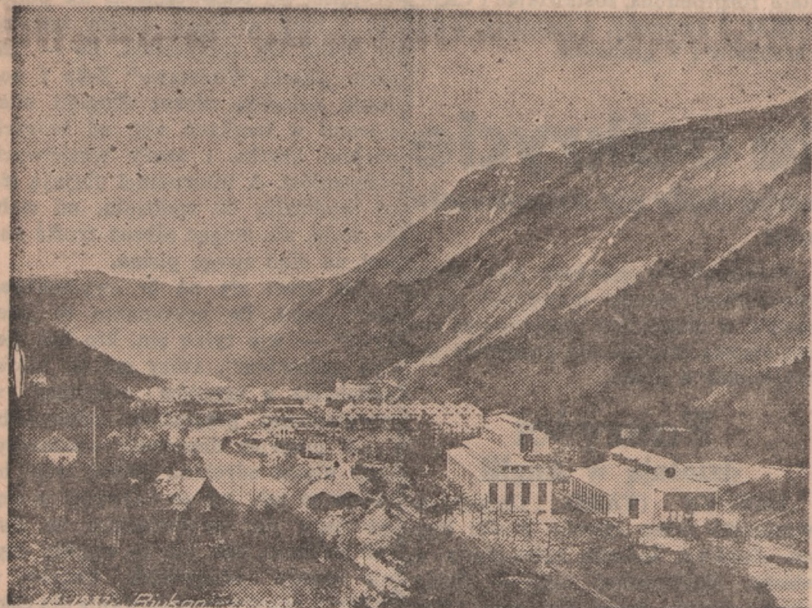
„Norsk Wydro”, nowoczesna fabryka nawozów sztucznych w Rjukan (Norwegia).
