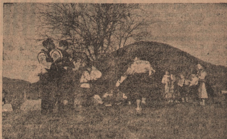
Mieszkańcy Ukrainy, po ogromnych zniszczeniach dokonanych przez Niemców, szybko zacierają rany zadane ich miastom i wsiom. Na gruzach i ruinach powstają jeszcze piękniejsze gmachy i osiedla. Przeorane czolgami pola zasiewają bujną pszenicą. W niedzielę, w dzień wolny od pracy młodzież wsi wesoło zabawia się przy dźwiękach muzyki. Wieczorem popłyną w dal tęskne, ukraińskie piosenki.
