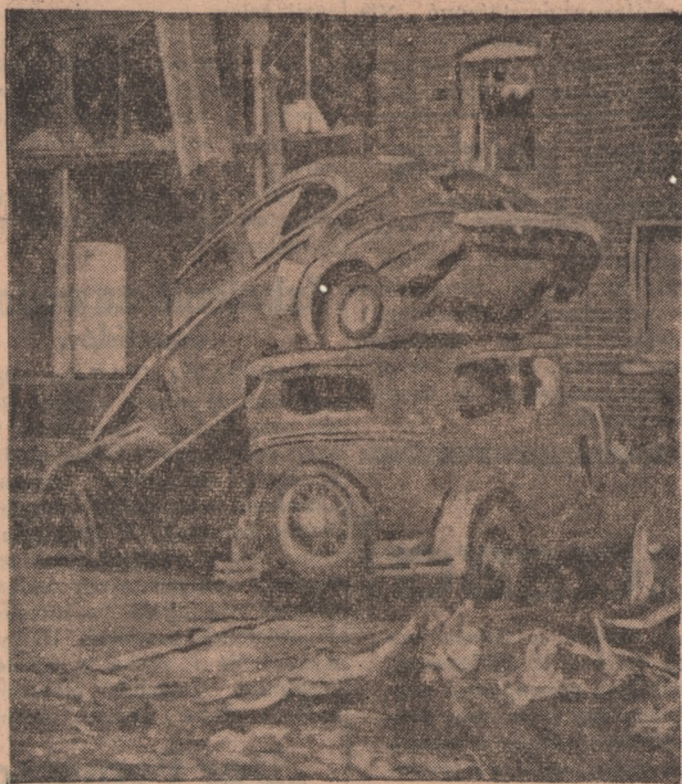
W Wells (Minnesota USA) przez miasto przeszła trąba powietrzna, rozrywając budynki i przewracając samochody jak popsute zabawki. Zniszczenia wywołane przez tornado urastają do tragicznie wielkich rozmiarów. Żadna siła ludzka nie byłaby zdolna spowodować takiej katastrofy.
