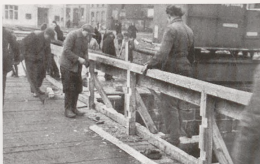
Budowa mostu drewnianego, 1945 rok
