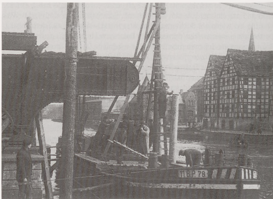
1945 rok, ulica Mostowa – budowa mostu
