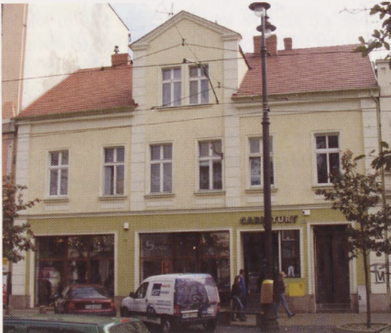
Odnowiony przez ADM budynek przy ul. Gdańskiej 40
