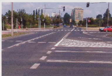
Ul. Wyszyńskiego po wykonanej przebudowie
