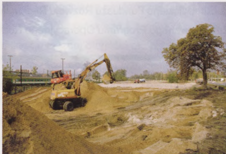
Ul. Artyleryjska – wykonywanie nasypu
