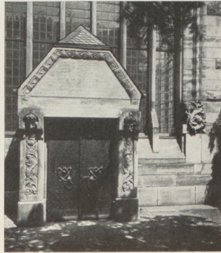
Abb. 88. Eingang zur Schutzhalle Freiberg i. Sa.
