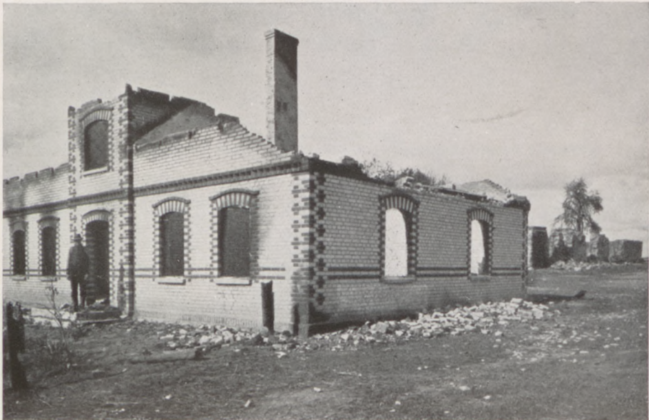
Abb. 37. Mörken Häßlicher Schmuck des unverputzten Kalksandstein-Mauerwerks mit roten Ziegelmusterungen. Das Zahnschnittband in Balkenhöhe und die vorgefragten Stürze der unnötig großen Fenster ziehen nur die Witterungsfeuchtigkeit in das Haus hinein. Aus der Sammlung des Herrn Geheimrat Fischer, Königsberg.
