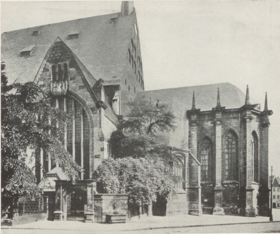
Abb. 86. Freiberg i. Sa. Schutzhalle vor der goldenen Pforte
