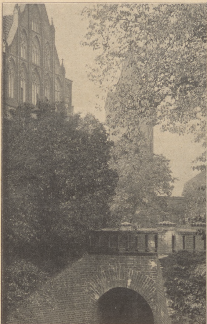
Burggrabenbrücke zum Mittelschloß.
