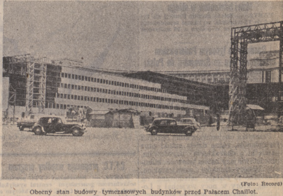
Obecny stan budowy tymczasowych budynków przed Pałacem Chaillet.
