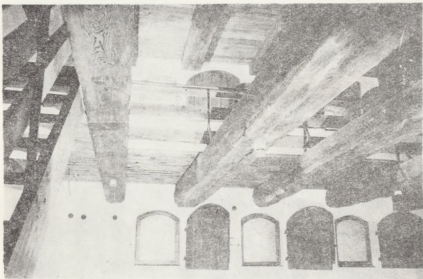
Wnętrze spichrza nr 13–15 z zachowanymi po adaptacji drewnianymi belkami stropowymi i widoczną przy ścianie okiennej galerijką
