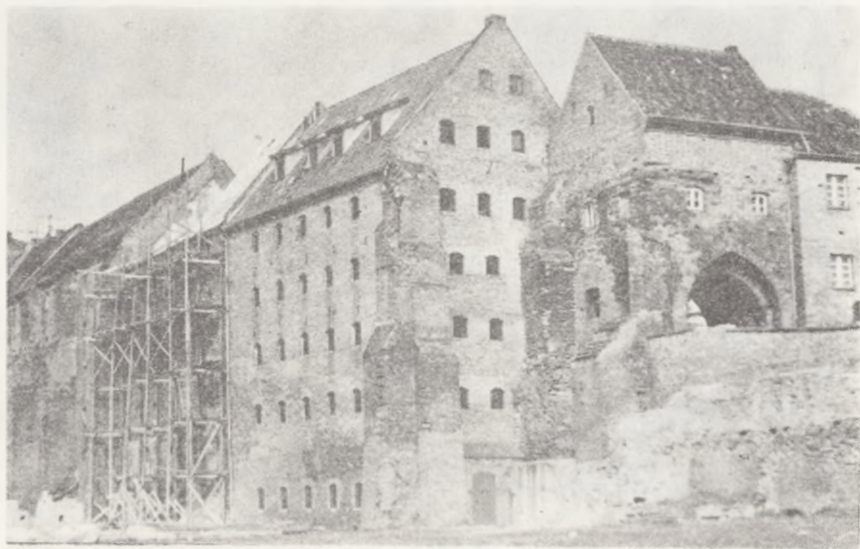
Widok na Bramę Wodną i spichrz nr 9 — po adaptacji oraz spichrze nry 11—17 — w trakcie prac konserwatorskich, stan z 1976 r.
