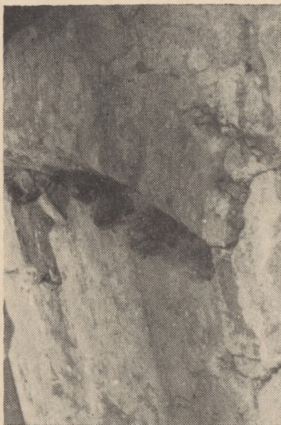
Fragment tuku otworu okiennego, romańskiego, odkrytego na ptn. ścianie kościoła w Mogilnie
