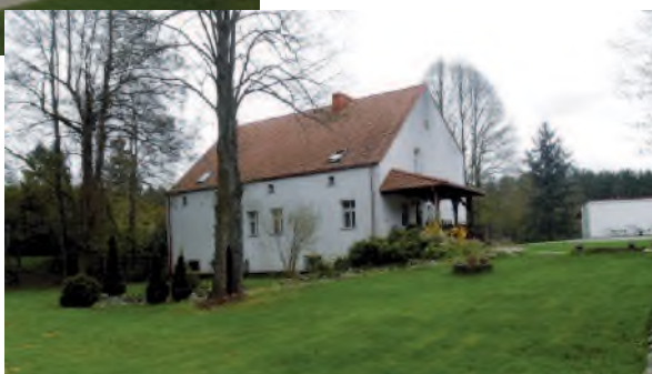
Fot. 3–4. Sennewitzmühle (Łąkomini) współcześnie (maj 2013). Bu- dynek na terenie posiadłości Źródło: Fotografie własne Autora
