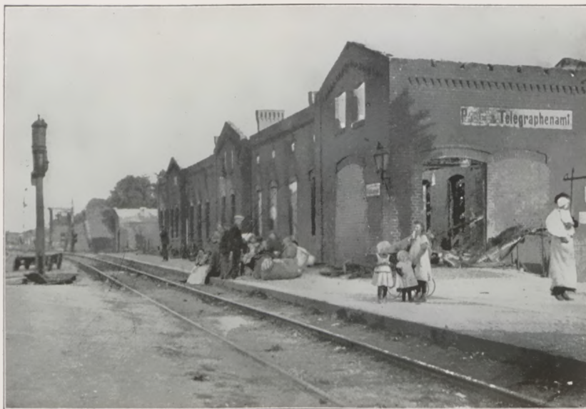
Von den Russen niedergebrannter Bahnhof bei Rosel.
