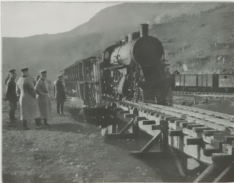
Das Werk deutscher Pioniere: Eine von den Serben zerstörte, in kürzester Frist wiederhergestellte Eisenbahnbrücke nahe Nisch.
