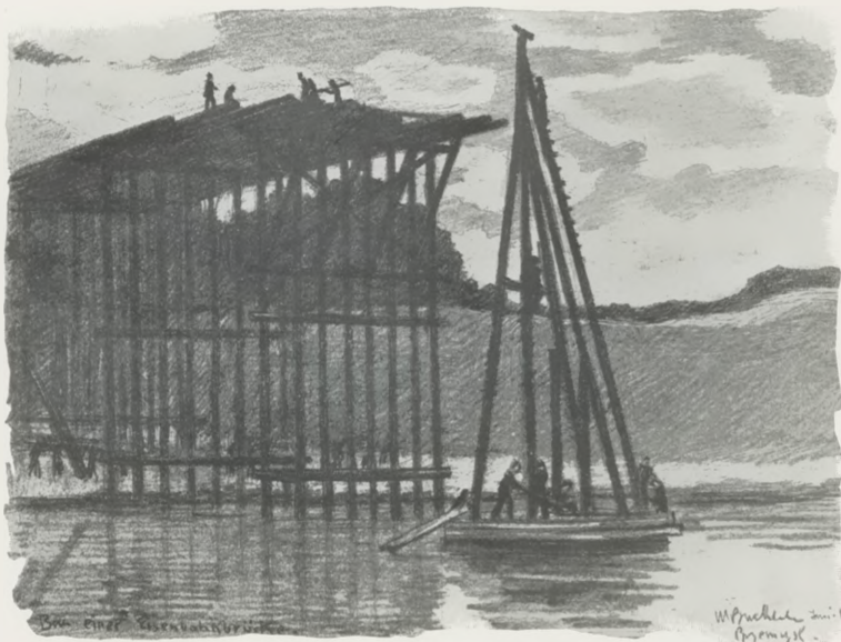
Bau einer Eisenbahnbrücke im Osten.
