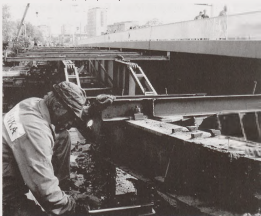
Rozpoczął się remont mostu Bernardyńskiego. Na ten czas jego rolę przejęła przeprawa tymczasowa. Fot. Marek Chelminiak
