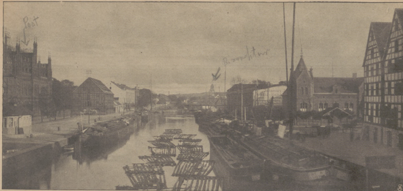
Bollwerk mit Bismarckturm.
