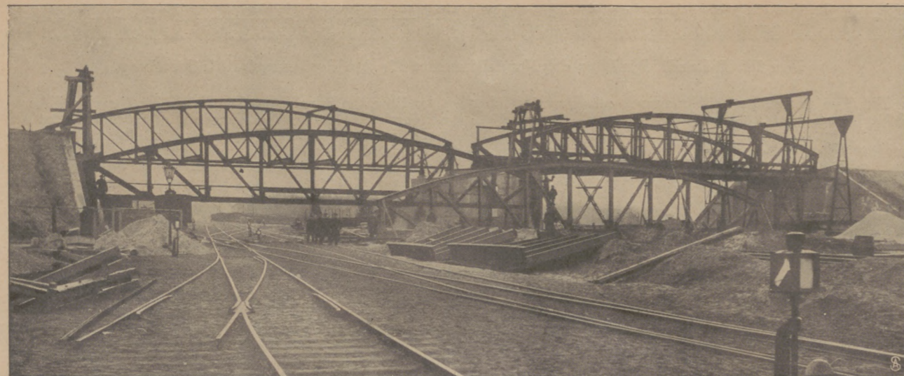
Montage der Chausseeüberführung auf Bahnhof Stolpmünde. Ausgeführt von F. Eberhardt, Bromberg
