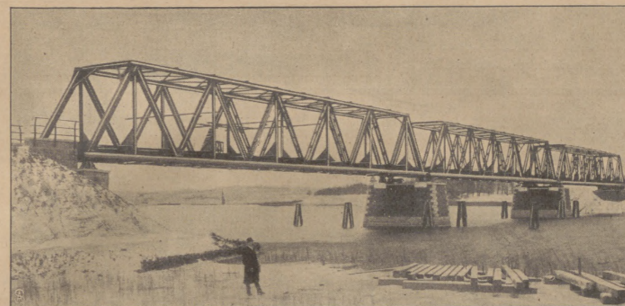
Brücke über das Taltergewässer der Neubaustrecke Sensburg-Nikolalken. Ausgeführt von der Firma F. Eberhardt, Bromberg, im Jahre 1910 für die K. E. D. Königsberg. Gesamtansicht der Brücke nach dem Einfahren der drei Überbauten.
