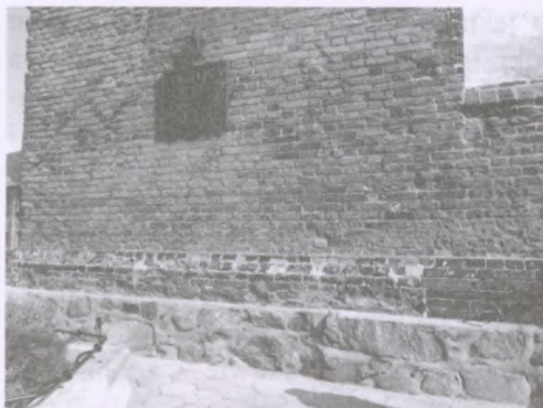
Zachodnia elewacja kościoła parafialnego w Chojnicach (Fot. M. Kołyszko).
