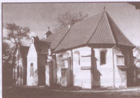
Kościół w trakcie rozbudowy, 2001 r., zbiory muzeum.
