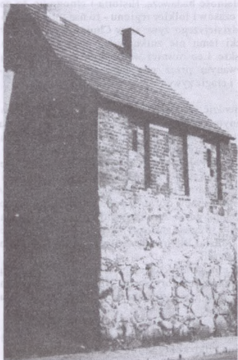
DOM SZEWSKI - znajduje się na murach obronnych między Basztą Szewską a Kurzą Stopą. Odbudowany przez Muzeum na fragmentach przebudowanej baszty. Oddany do użytku w 1979 r. Obecnie znajdują się w nim magazyny i pracownia konserwatorska.
