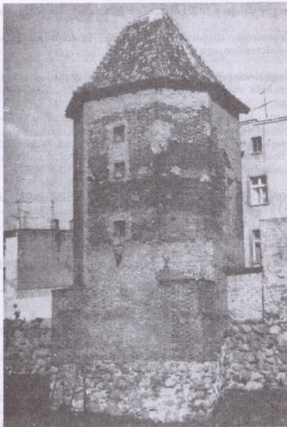
BASZTA WRONIA - usytuowana przy ulicy Podmurnej między Bramą Człuchowską a ulicą Młyńską. W przeszłości służyła jako więzienie dla pospólstwa. Odrestaurowana w 1974 r. Obecnie znajdują się w niej pomieszczenia administracyjne.
