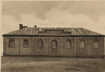
Hala gimnastyczna w budowie.
