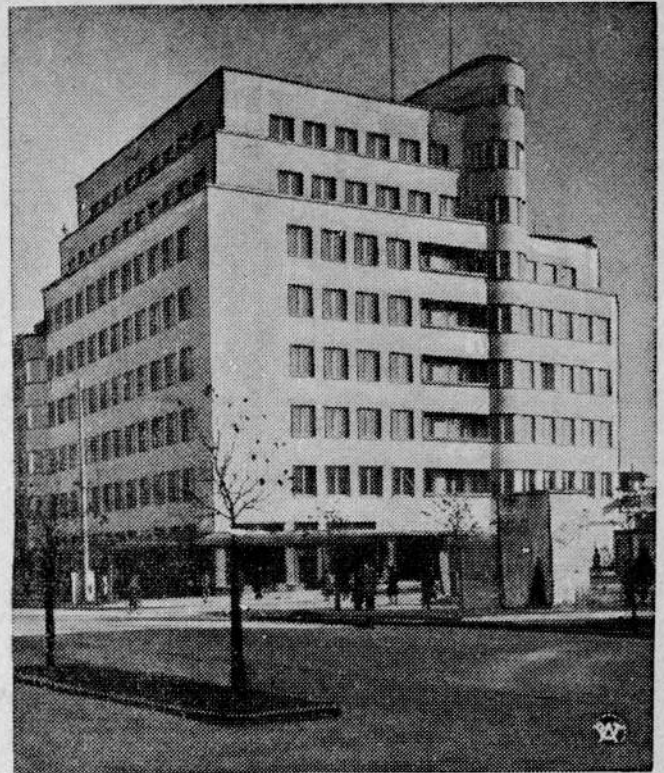
W Gdyni odbyło się poświęcenie nowego 7-piętrowego gmachu czynszowego.
