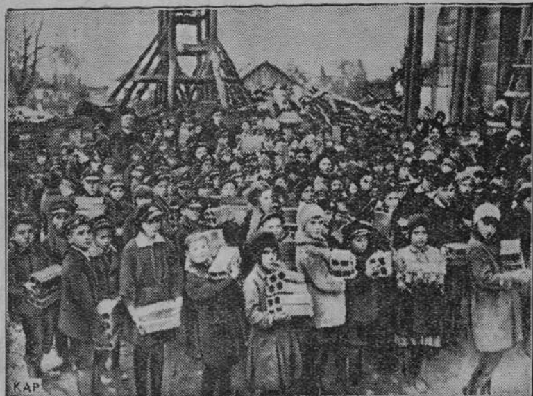
Dzieci pomagają przy budowie kościoła-pomnika w Kowlu.
