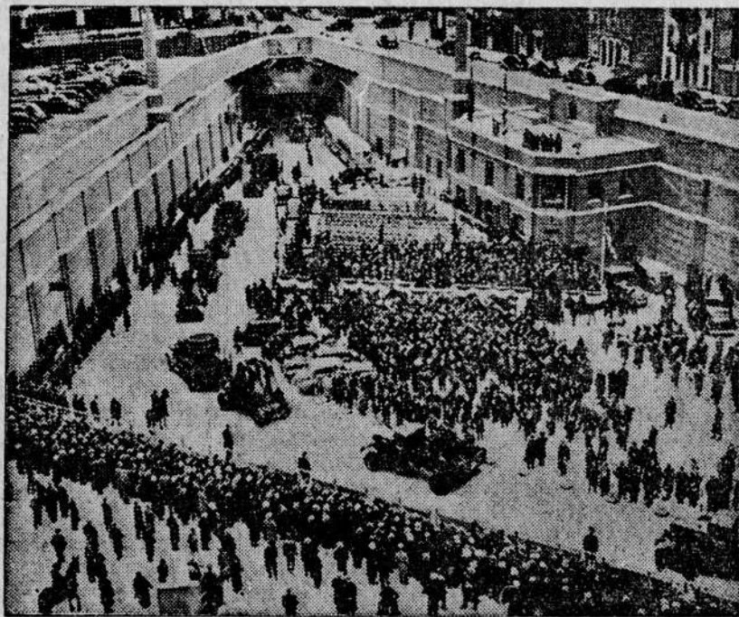
Tunel w New Yorku pod korytem rzeki Hudson.
