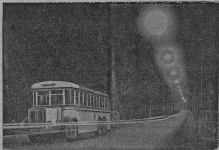
Na szosie automobilowej Berlin — Hamburg zaprowadzono nowy rodzaj oświetlenia lampami, zawierającymi gazy natronowe. Lampy te wydzielają znakomitą jasność i umożliwiają b. szybką jazdę także nocą.
