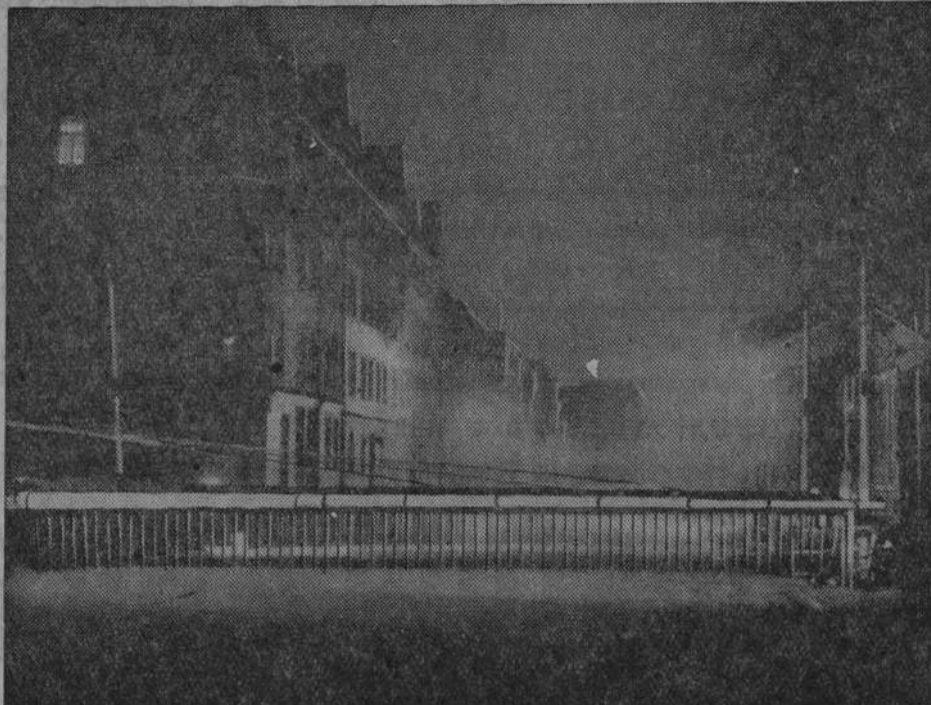
Pewien niemiecki inżynier wynalazł sposób oświetlania kolejowych zapór drogowych. Zapora ta przy opuszczeniu włącza automatycznie reflektory, oświetlając przejazd. Uchroni to w przyszłości pojazdy mechaniczne od zderzeń z pociągami, bądź też z samą zaporą.
