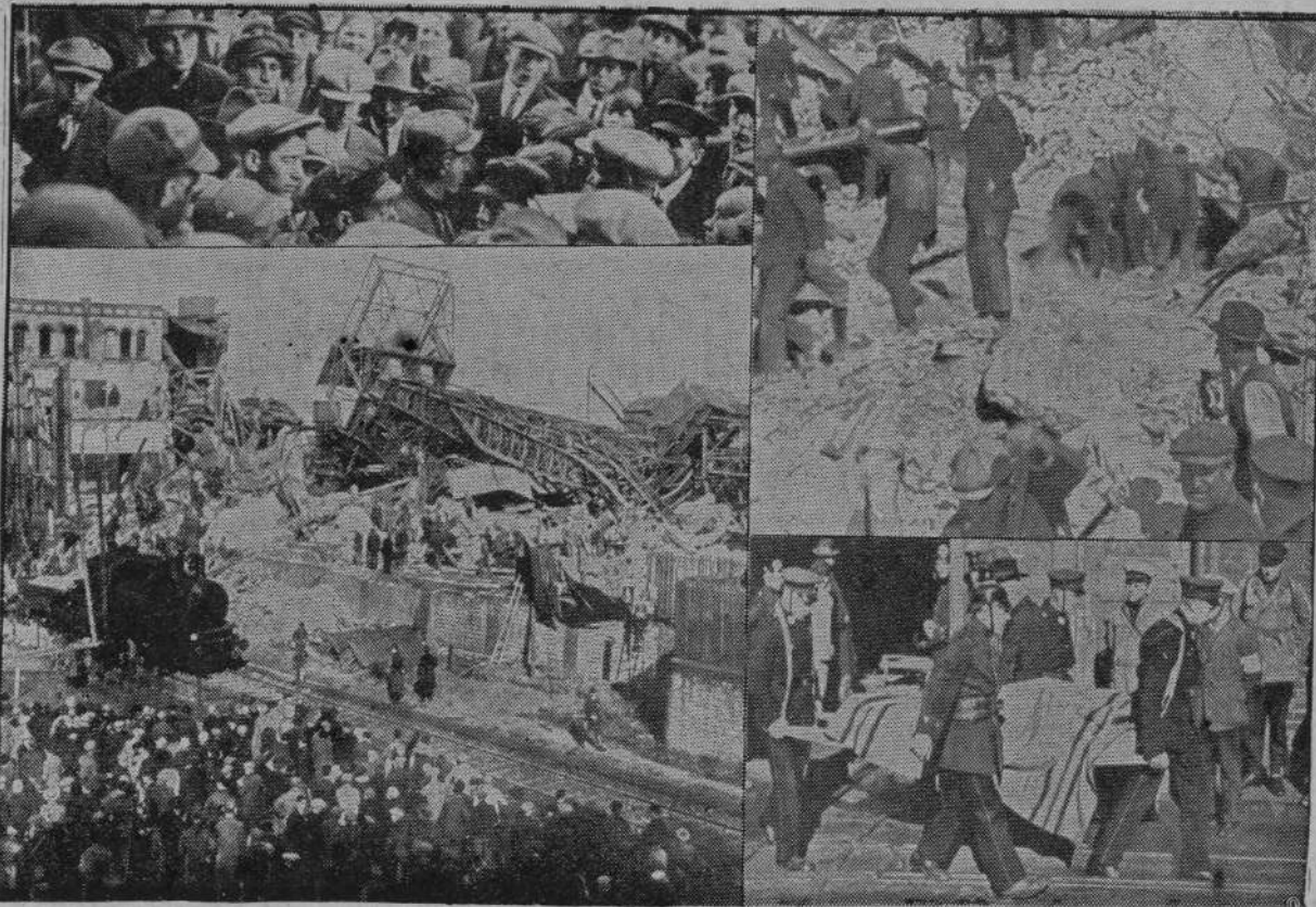
U góry lewo: Uratowani opuszczają miejsce zgrozy. — Na dole lewo: Zniszczenia spowodowane katastrofą na wierzchu kopalni. — U góry prawo: Wydobywanie ofiar z pod gruzów. — Na dole prawo: Transport zabitych i rannych.
