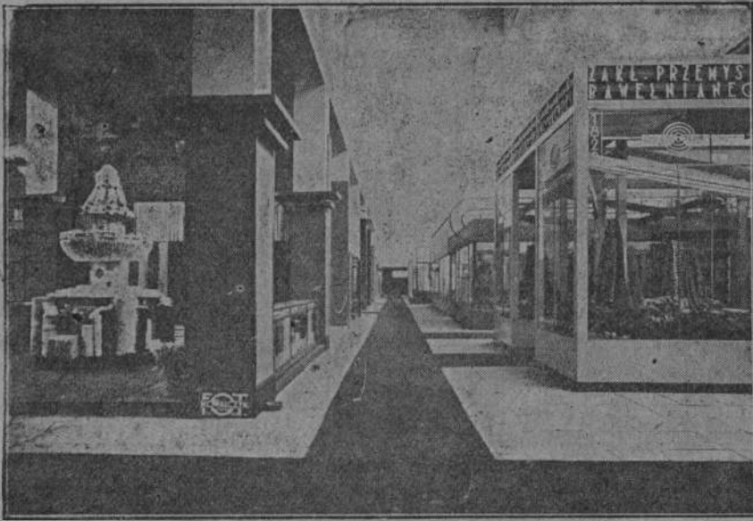
Wnętrze hali wstępnicy na P. W. K.
