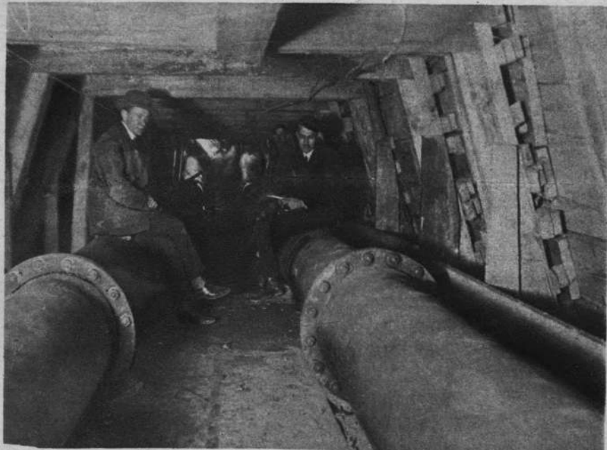
1) Odbudowany częściowo most im. księcia Poniatowskiego na Wiśle. 2) Budowa tunelu w Aleji 3-go maja. 3) Fragment odbudowanego mostu. 4) Wylot kanału burzowego. 5) Budowa wjaduktu nowego mostu kolejowego. 6) Przewody wodociągowe łączące wschodnią część miasta z zachodnią, obnażone obecnie przy budowie tunelu. 7) Obecny stan robót w śródmieściu.
