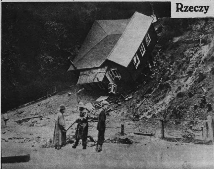
Ostatnimi czasy w Kalifornji zerwała się gwałtowna burza, która poczyniła wielkie szkody, niszcząc kilkadziesiąt domów mieszkalnych. Ilustracja nasza przedstawia jeden z takich domów, porwanych przez huragan.
