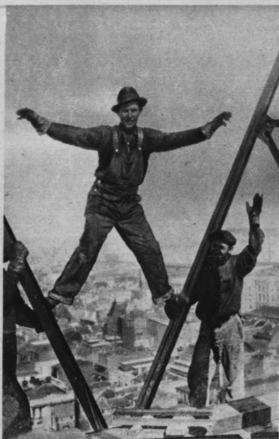
Człowiek bez nerwów. Jak bardzo przyzwyczał się można do niebezpieczeństwa, wskazuje fotografia trzech robotników na amerykańskim drapaczu chmur, którzy nie kontentują się swoim powietrznym zawodem, ale jeszcze wykonują szczególne sztuki na rusztowaniu żelaznym na wysokości 50 m.
