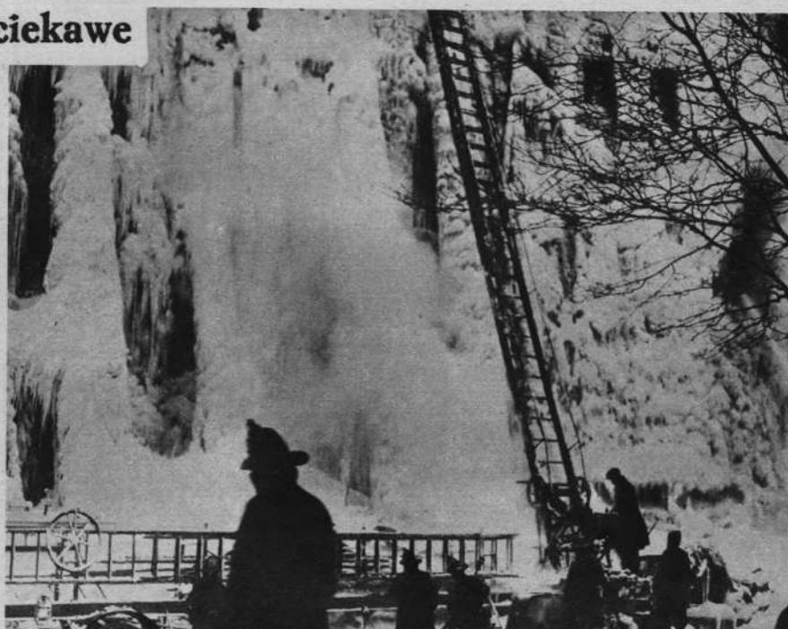
Zdjęcie z pożaru w Montreal (Kanada), w czasie którego straż ogniowa musiała pracować przy temperaturze -35^{\circ}\text{C} . Woda z hydrantów momentalnie zamarała, pokrywając cały budynek grubą warstwą lodu.
