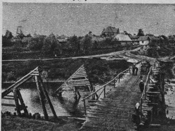
Prowizoryczny most na Bużu w zniszczonej przez wojnę miejscowości.
