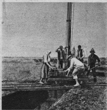
Wydobywanie torfu maszyną-kopaczką z głębokości 3—5 metrów pod powierzchnią ziemi.
