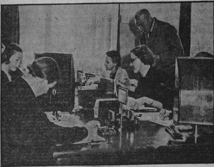
Sala Morse'a. Na stole widać dwa telegrafy Morse'a i dwa stukacze. (Dalsze objaśnienia w tekście).
