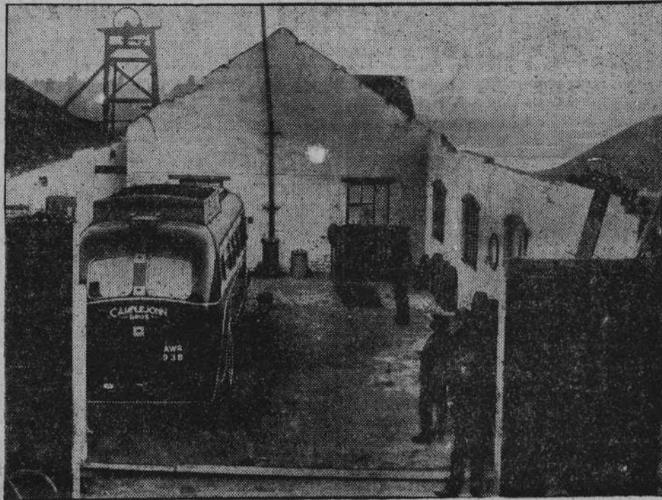
Naskutek gwałtownych burz, jakie ostatnio przeszły nad Anglią, uległo zniszczeniu wiele domów a nawet całych ulic. Szkody są tak wielkie, że trudno je narazie obliczyć. Ilustracja przedstawia całkowicie zniszczony garaż w Low Valley, Wombell w Yorkshire.
