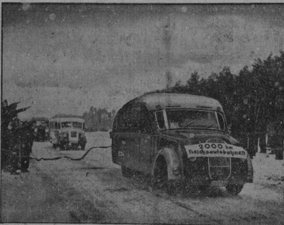
Niemcy wykończyli ostatnio nowy odcinek budowanej autostrady, która łączyć będzie wszystkie ważniejsze miejscowości Niemiec. Osięgnęły w ten sposób 2000 kilometrów.
