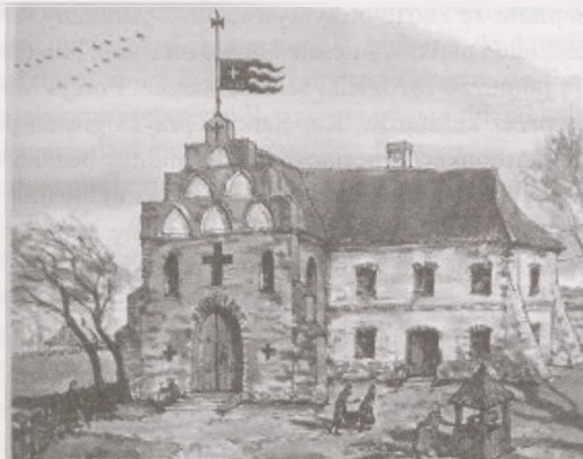
Ryc. 4. Kościół szpitalny św. Krzyża M. Boguszyński, Od warsztatu balwierskiego do szpitala klinicznego , Bydgoszcz 2008
