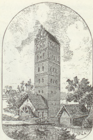
Abb. 5. Der ehemalige Wachturm.
