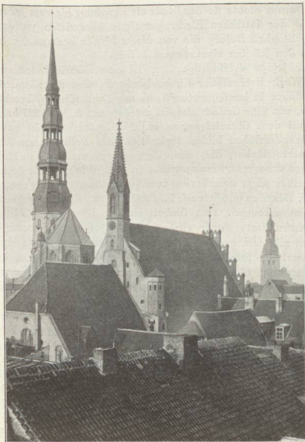
Abb. 18. Die St. Petri-, St. Johanns- und Domkirche. Nach einer Aufnahme des Architekten W. Bockslaff.
