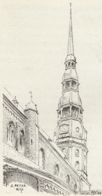
Abb. 16. Der Turm der St. Petrikirche.
