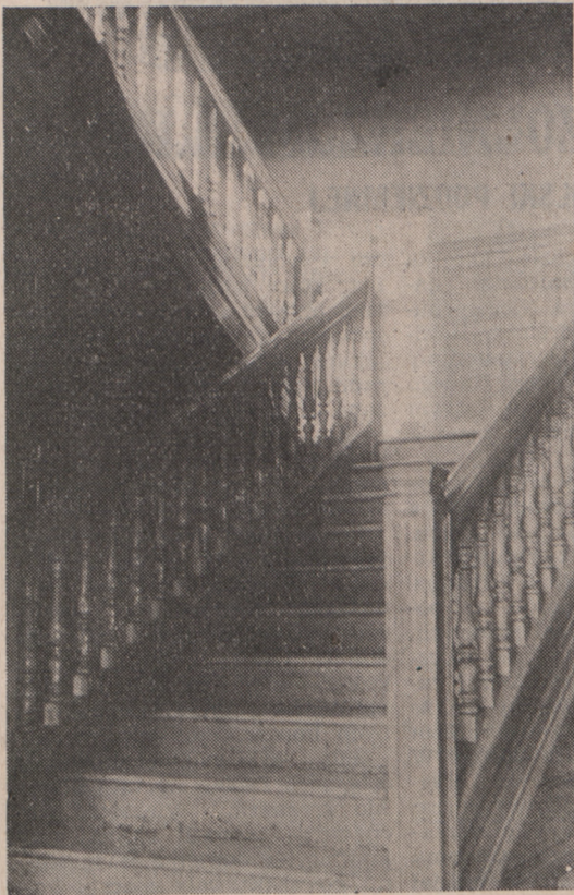
Klatka schodowa aneksu.
