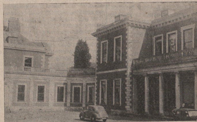
Fronton głównego gmachu i korytarz łączący gmach z aneksem.
