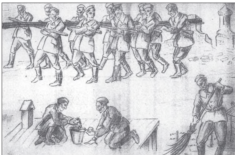
Prace remontowe i porządkowe na terenie obozu.
