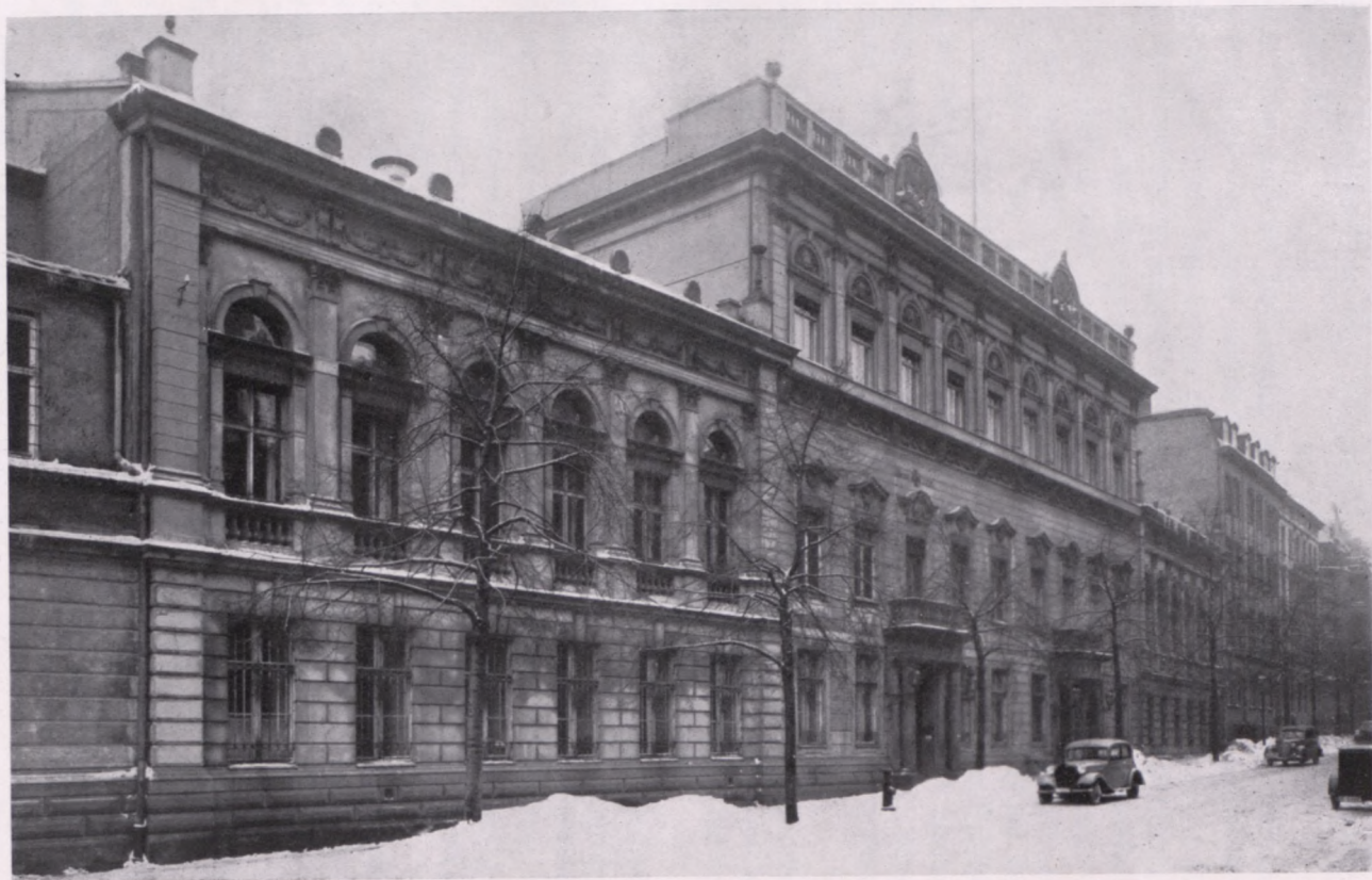
Landhofmeisterstraße 16/18 nach dem im Jahre 1887 vollendeten Umbau.
