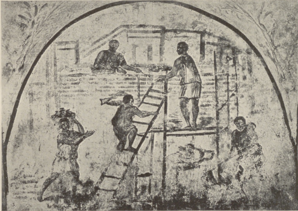
119. Bauarbeiten unter der Leitung des Trebius Justus. Wandgemälde aus einer Gruft an der Via Latina.
