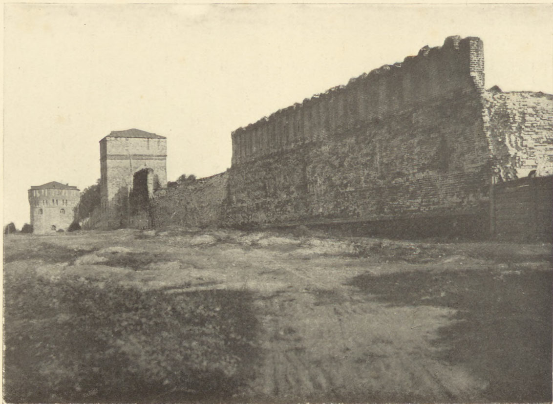
MURAILLE D'ENCEINTE DE LA VILLE DE SMOLENSK. ÉTAT ACTUEL
