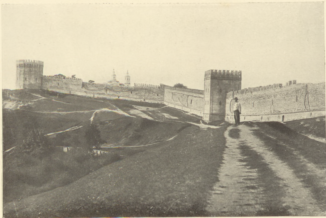
MURAILLE D'ENCEINTE DE LA VILLE DE SMOLENSK. ÉTAT ACTUEL
