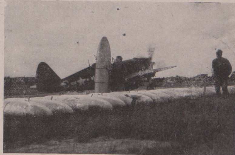
Dodatkowe tanki z benzyną wyrównane w szereg na lotnisku i gotowe do podcepienia; to one wraz z innymi właściwościami "Thunderbolta" czynią z niego maszynę o wielkiej wartości bojowej
