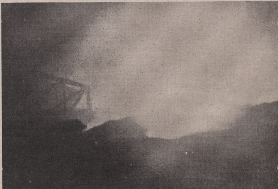
Wysadzenie mostu na rzece Wistoká w nocy z 5/6 kwietnia b.r.
