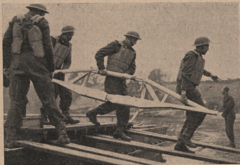
Praca przy budowie mostu
